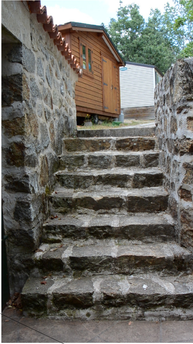
Escalera exterior del Camping (4)
